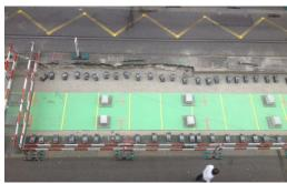
Verlegen der Betonplatten und -moellons auf verklebte Dämmmatten.
