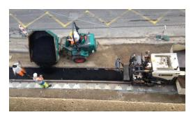
Seitlich der Gleistragplatte fertig eingebrachte und verdichtete Fundationsschicht.
