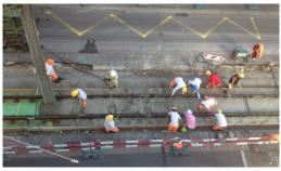
Einbringen des Gleisbetons und anschliessendes Abtalochieren.
