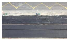
Fertig eingebauter Deckbelag zwischen den Gleisen und am rechten Fahrbahnrand.
