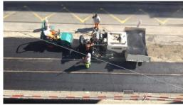
Einbauen der Tragschicht mittels Belagsfestiger und anschliessendes Verdichten mit der Vibrowalze.
