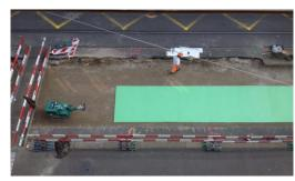
Verlegen der Dämmplatten auf die Planie.
