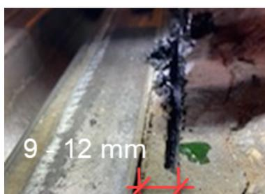
Abb.03-2: Fräsbreite 9 bis 12mm neben Schiene
