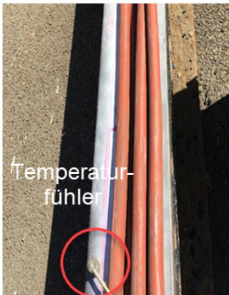
Abb. 20-1: Temperatursensor auf Fahrkopf
