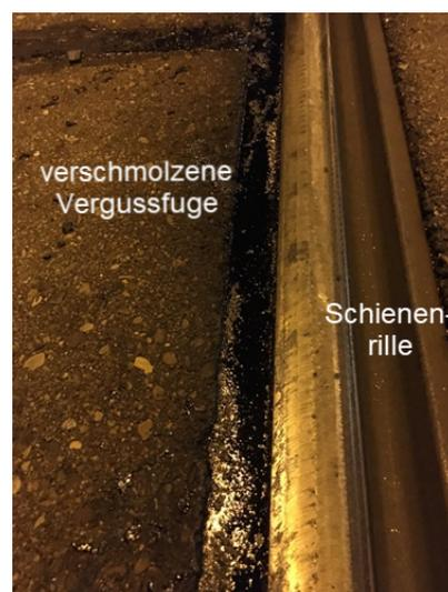
Abb. 03-3: Nach dem Schweissen verschmolzene Vergussfuge
