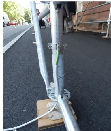
Der Anschluss an ein Gerüst ist mittels Erdleiterbride 50mm<sup>2</sup> zu erstellen (Abb.1). Beim Anbringen der Erdleitung an einen Kranbock oder an eine Metallkonstruktion, muss ein geeigneter Erdungspunkt erstellt werden (Abb.2). Sämtliche Metallischen Teile im Fahrleitungsbereich sind mit dem Erdleiter zu verbinden.
