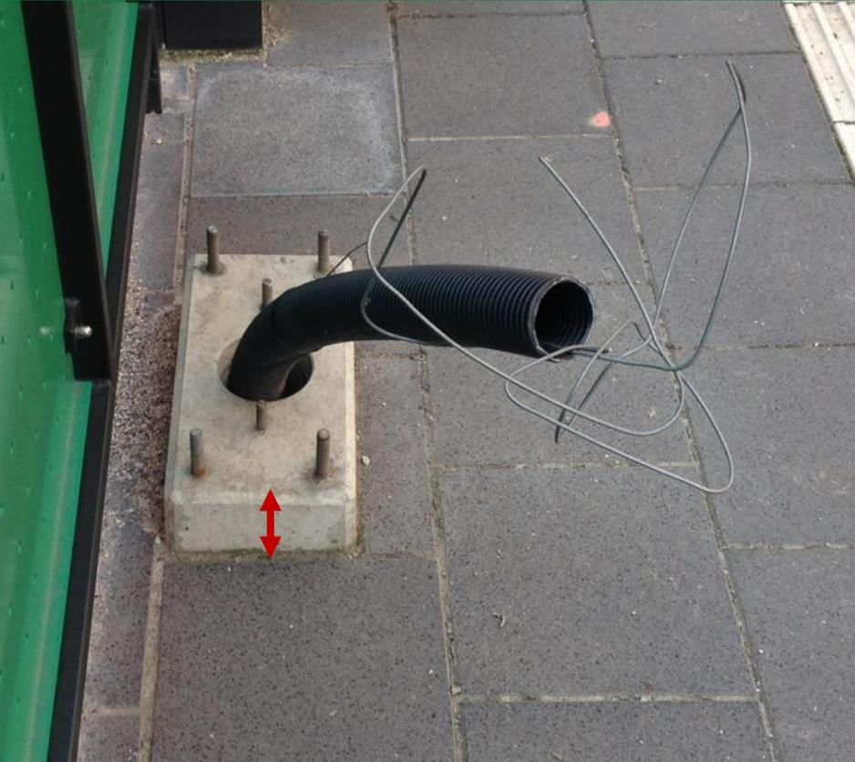
Höhe Oberkant Betonfundament bis Fertigbelag 8cm – 10cm
