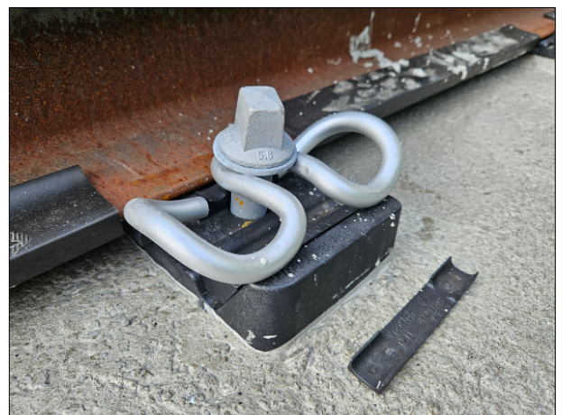
Abbildung 12: Korrekt gereinigter W-Tram-Anker
