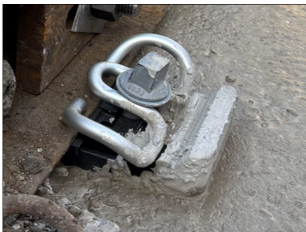
Abbildung 11: So nicht, ungereinigter Anker
