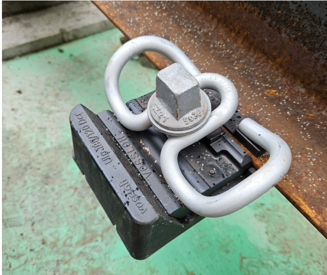
Abbildung 13: vormontierte Spannklemme mit Isolierclip
