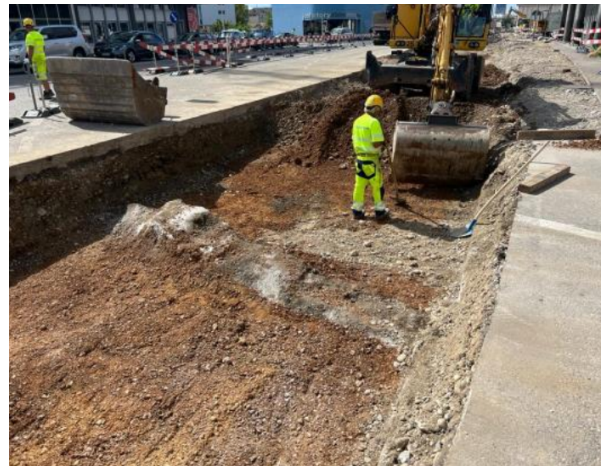
Abbildung 3: Bodenaushub im Gleisbereich
