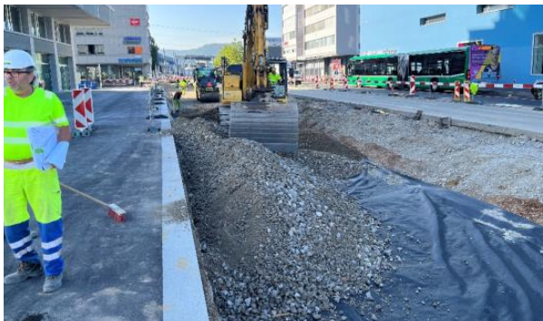
Abbildung 4: Einbau einer Fundationsschicht auf Geotextilen
