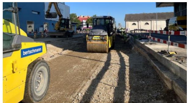
Abbildung 5: Einbau und Verdichtung einer Feinplanie
