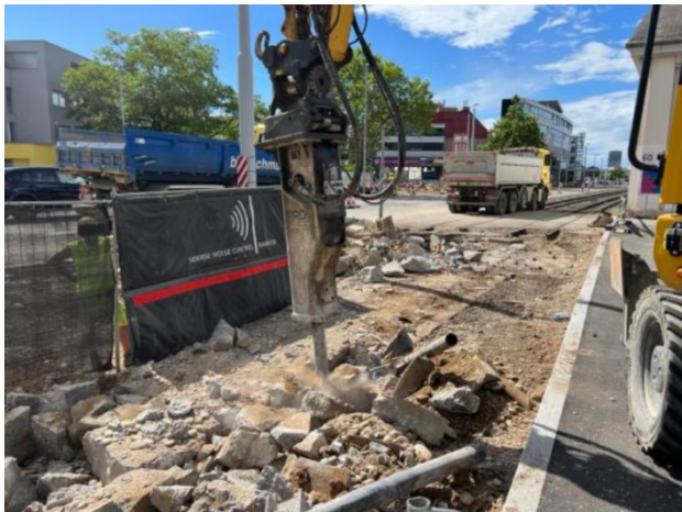
Abbildung 2: Abbruch der Betontragplatte
