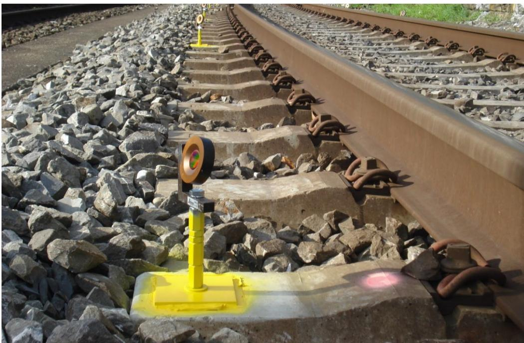
Abb. 23: Monitoring-Primen mit Konsolen direkt auf Schwelle geklebt
