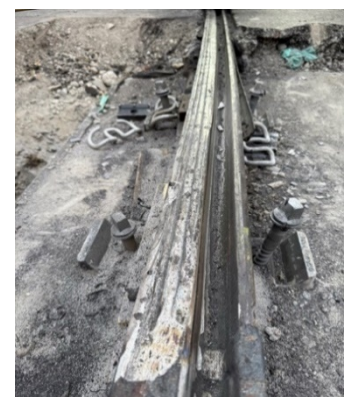
Abb. 11: Geschweisst, vor dem Profilschliff
