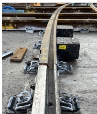
Abb. 9: Höhenversatz alt zu neu 9 mm
