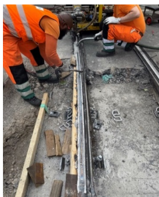
Abb. 10: UP-Schweißen der Auflauframpe
