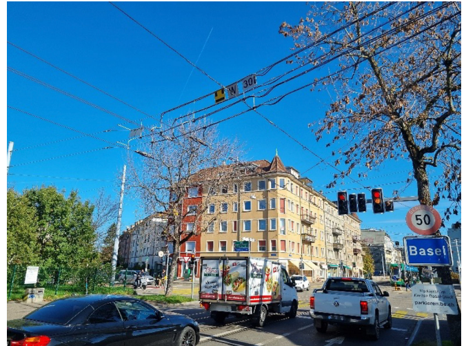
Abbildung 26: Fahrleitungsanlage Morgartenring, Blickrichtung Nordost
