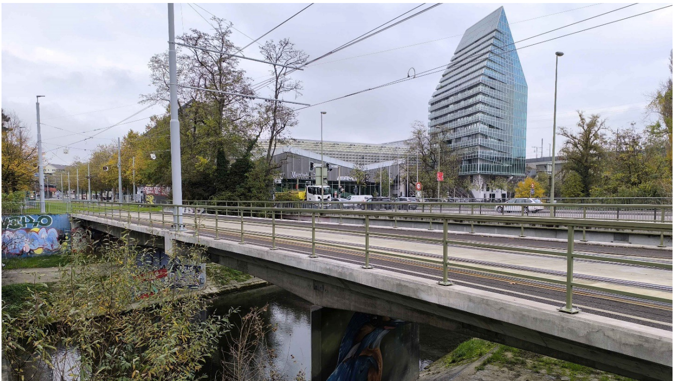
Abbildung 14: Birsbrücke St. Jakob
