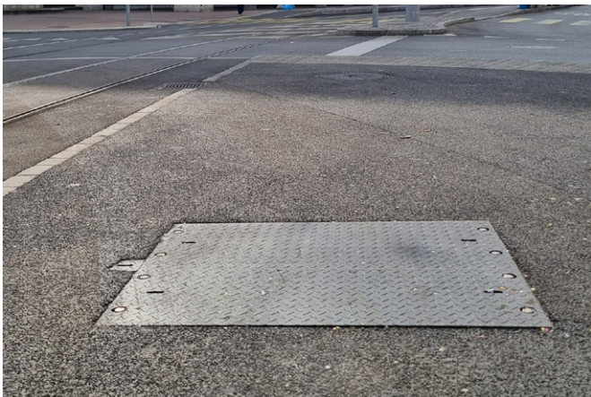
Abbildung 38: Bodenkasten der Schmieranlagensteuerung Nr. 85 beim Kunstmuseum
