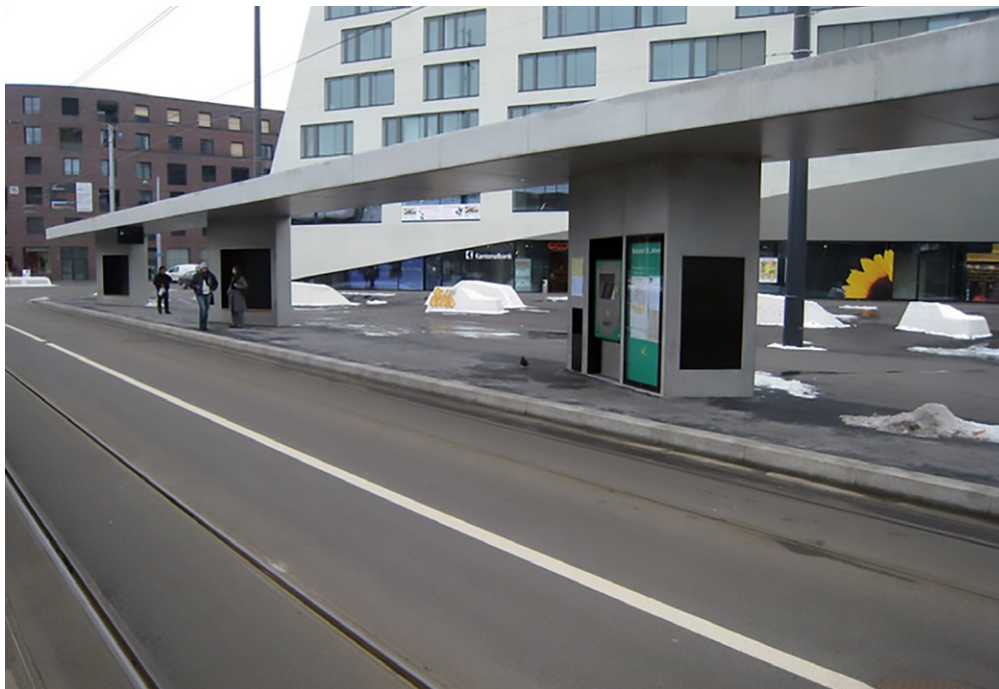
Abbildung 57: Wartehalle «Spezial» an der Haltestelle Bahnhof St. Johann
