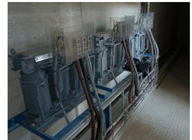
Abbildung 42: 40V Transformatoren Belagsheizung Hiltalingerbrücke
