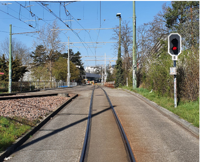
Abbildung 35: Bahnsignale der Bahnsicherungsanlage «Schänzli», Blickrichtung St. Jakob
