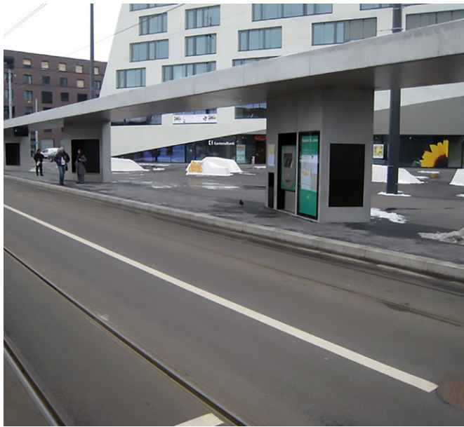
Abbildung 56: Wartehalle «Spezial» an der Haltestelle Bahnhof St. Johann
