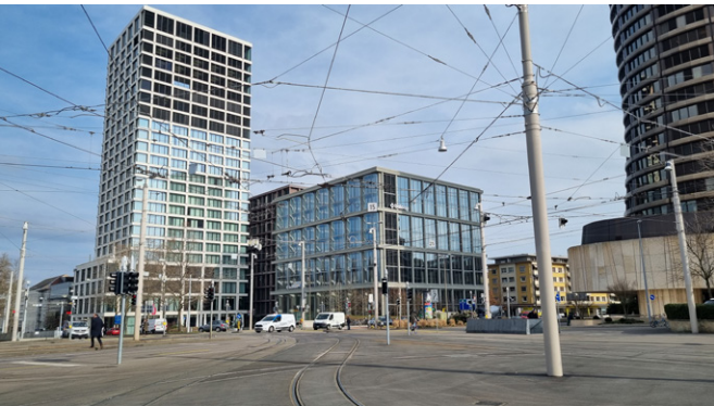
Abbildung 26: Fahrleitungsanlage Centralbahnplatz, Blickrichtung Südwesten
