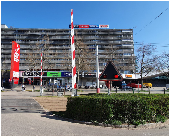
Abbildung 30: Schrankenanlage Grosse Allee
