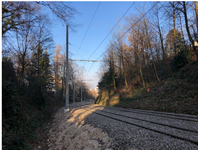
Abbildung 15: Schottertrasse Wolfschlucht nach der Erneuerung 2021/2022
