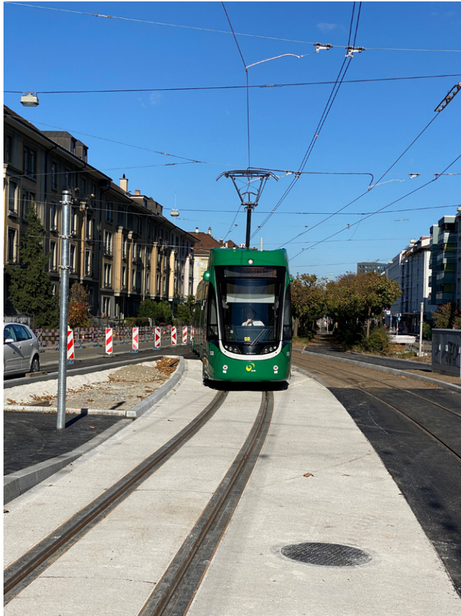
Abbildung 16: Feste Fahrbahn Margarethenstrasse nach der Erneuerung im Jahr 2021
