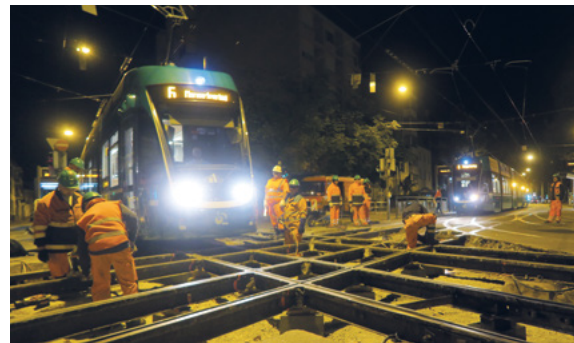
Bauen unter Betrieb
