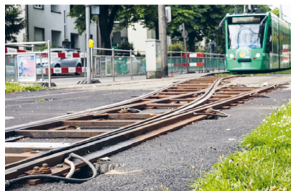
Bauen mit Einspurbetrieb
