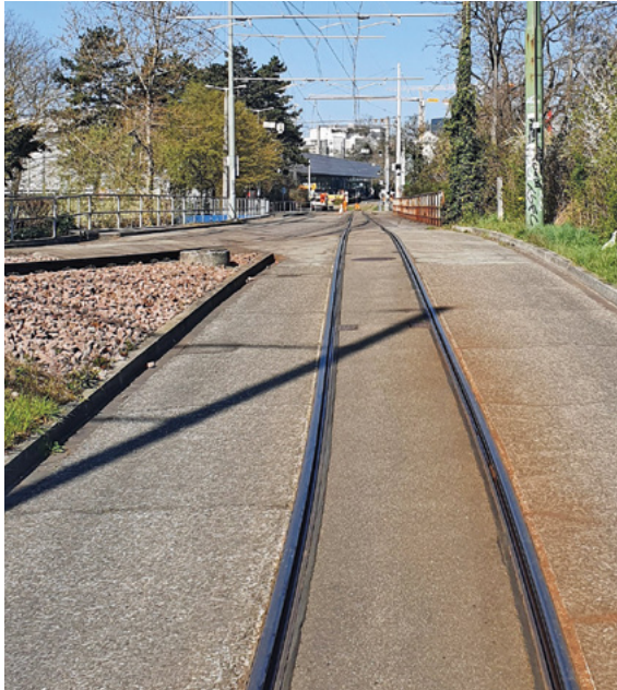
Bahnsignal der Bahnsicherungsanlage «Schänzli» Blickrichtung St. Jakob
