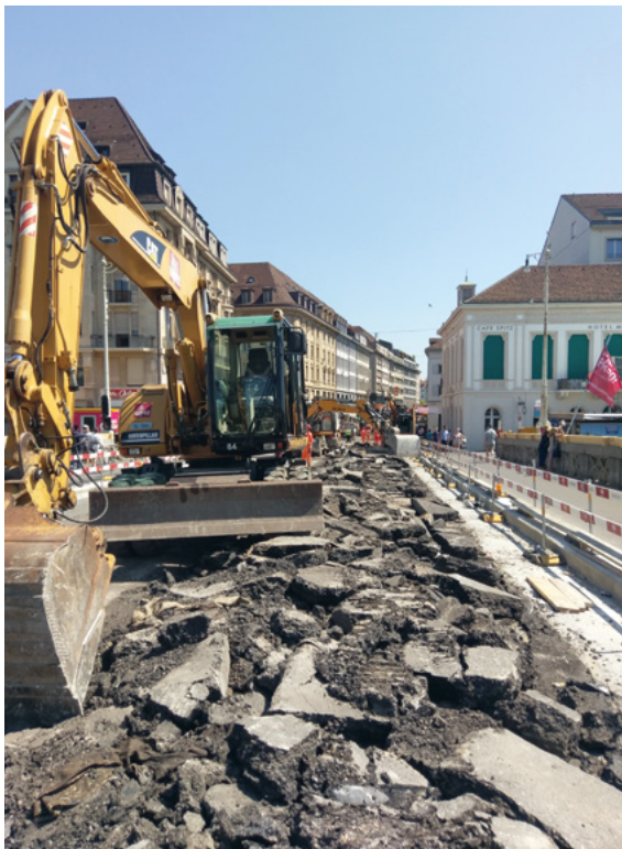
Bauen mit Vollsperrung
