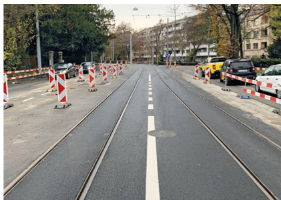
Feste Fahrbahn St. Alban-Anlage
