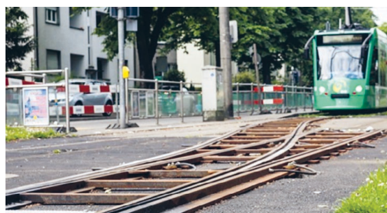
Bauen mit Einspurbetrieb
