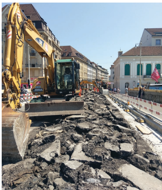
Bauen mit Vollsperrung
