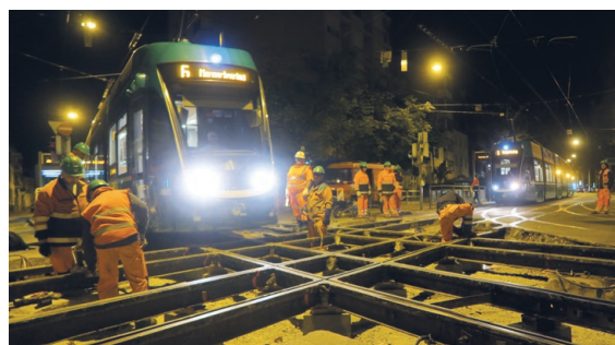
Bauen unter Betrieb
