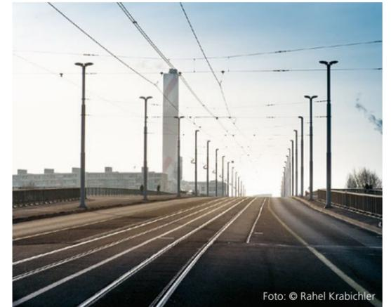
Der Zustand der Fahrleitungsanlagen wird auf der Grundlage der erwarteten Nutzungsdauer von 40 Jahren bestimmt. Dabei wird ein progressives Alterungsverhalten zugrunde gelegt.
