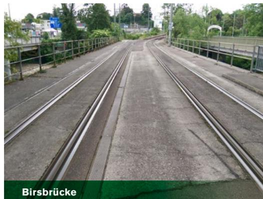
Die Brücke wurde zuletzt 2011 einer vollständigen Zustandsuntersuchung unterzogen. Zu diesem Zeitpunkt konnte keine Beeinträchtigung von Tragfähigkeit und/oder Gebrauchstauglichkeit des Bauwerks festgestellt werden. Eine Folgeuntersuchung wird im 2017 als Basis für den geplanten Gleisersatz in 2020 beauftragt. Im Zuge dieser Arbeiten soll die Brücke ebenfalls saniert werden.
